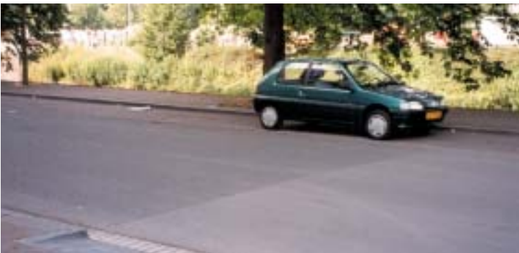
Figuur 5 Overgang van dichte deklaag naar tweelaags ZOAB
