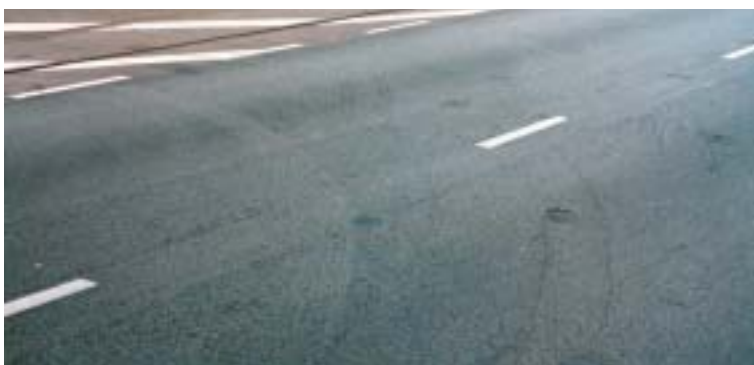
Figuur 3 Rafeling tweelaags ZOAB t.g.v. wringende belastingen
