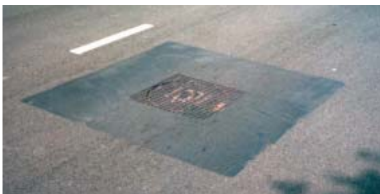
Figuur 8 Reparatie gaten rondom een putdeksel met gietasfalt
