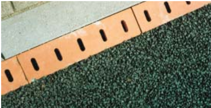
Figuur 6 Doorgaande gootconstructie bestaande uit keramische elementen
