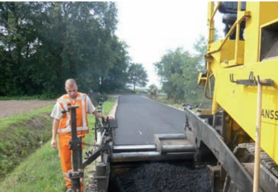
Aanbrengen onderlaag is net als traditioneel asfalt
