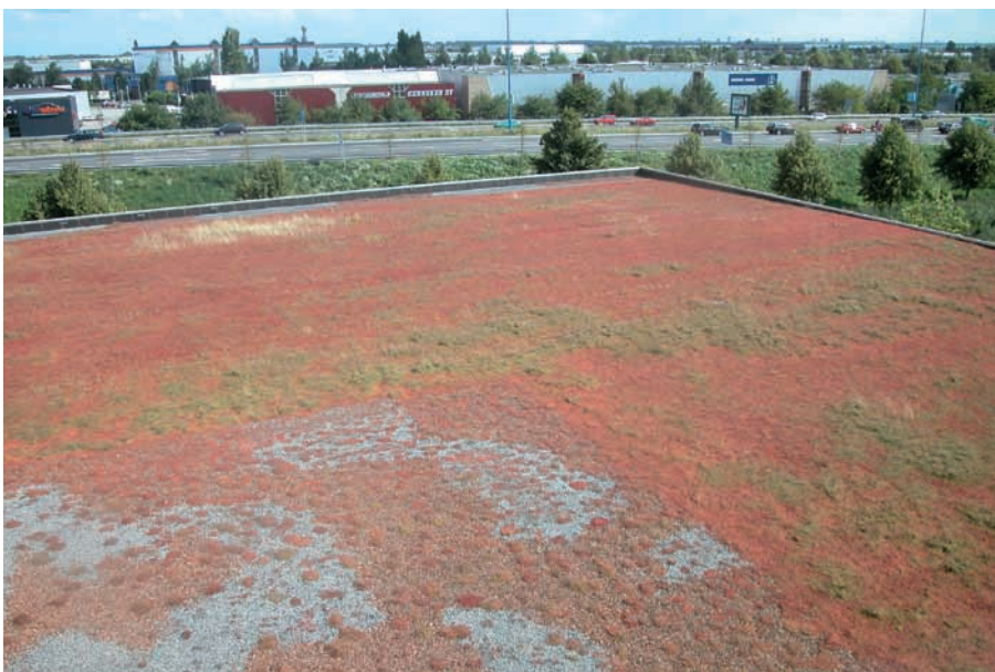
Ook het dak van de parkeergarage van het Bouwhuis is van een groen dak (met rode sedum) voorzien
