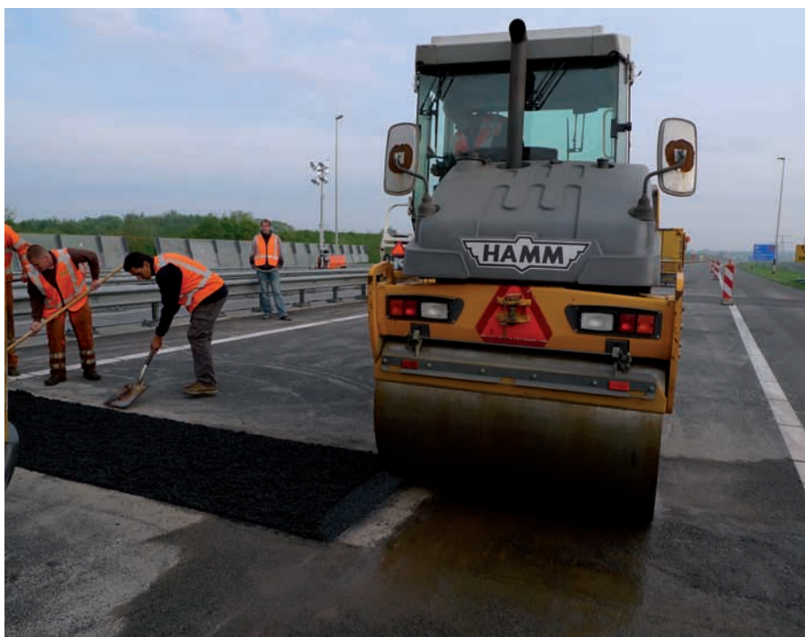
Afwalsen van de asfaltdeklaag
