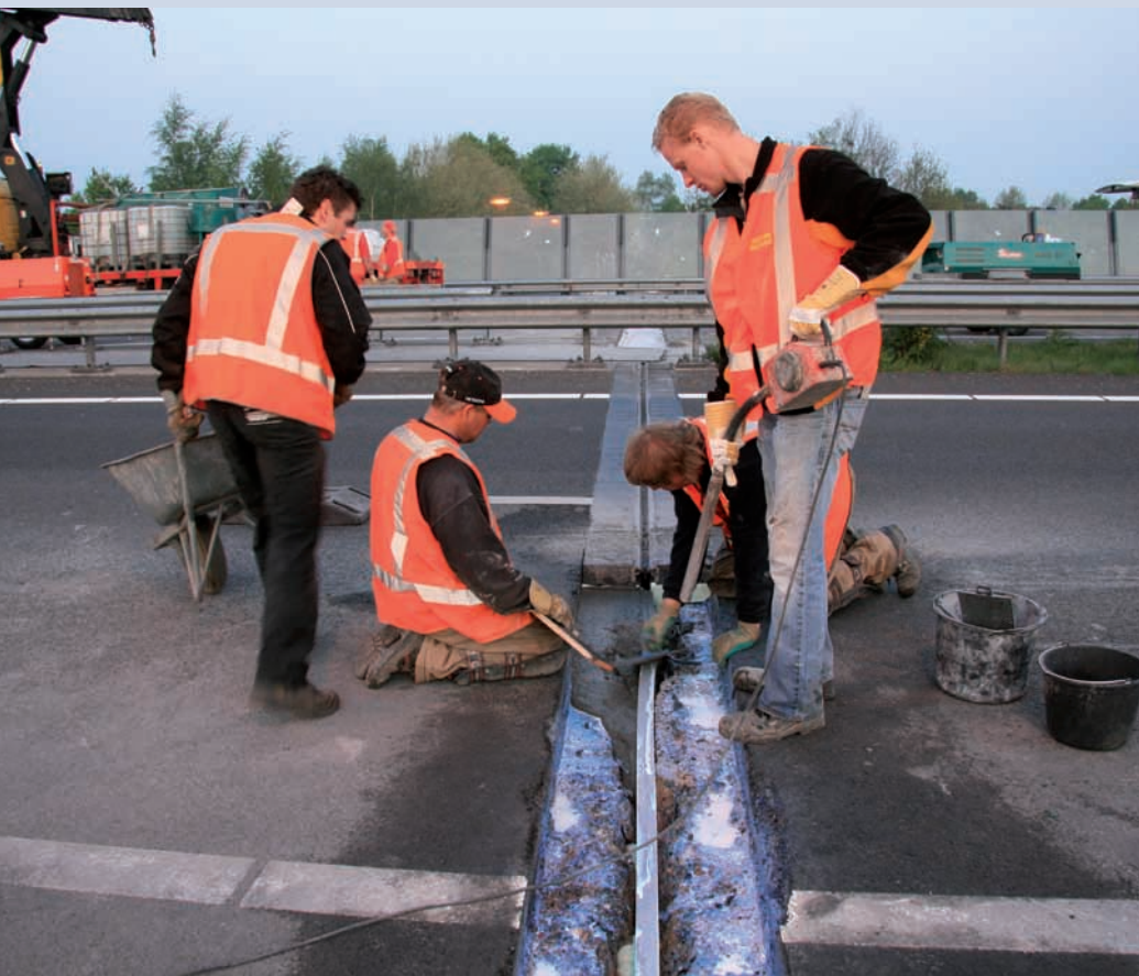
De voegkanten worden gerepareerd na het slopen van de harde voegovergang
