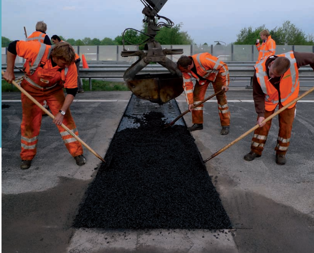
De asfaltdeklaag wordt aangebracht op de rekspreidende inlage
