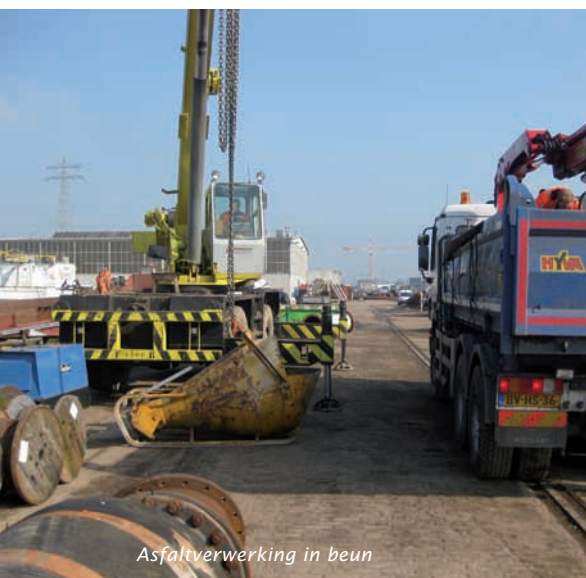
Laden kubel met waterbouwasfalt
