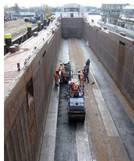
Zorgvuldige randafwerking om het drainage systeem open te houden
