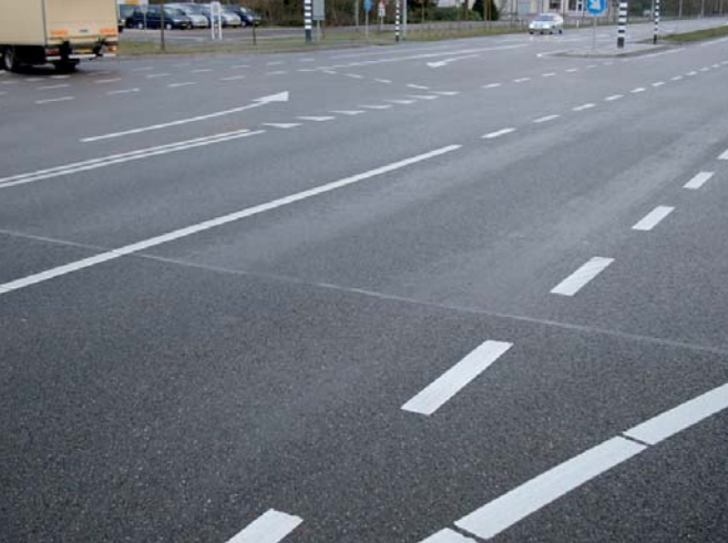
Overgang SMA gemodificeerd - niet gemodificeerd
