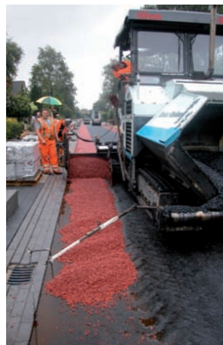
Asfaltmachine pakt rode asfalt tussen schot en uiteinde balk. Via de hopper wordt het zwarte asfalt gespreid
