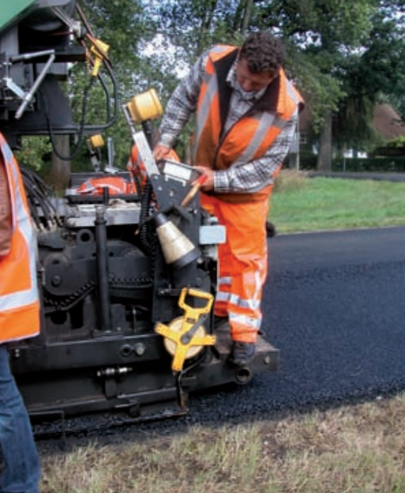
De balkman houdt breedte en dikte goed in de gaten.
