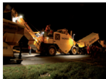
Shuttle Buggy in actie op de A35 bij de uitvoering van de pilot van de RWS prijsvraag “Schoner, Stiller en Homogener Asphalt”
