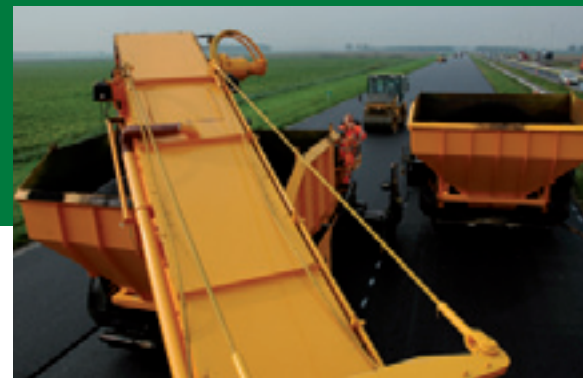
Inzetbakken in de hopper van de asfaltspreidmachine
