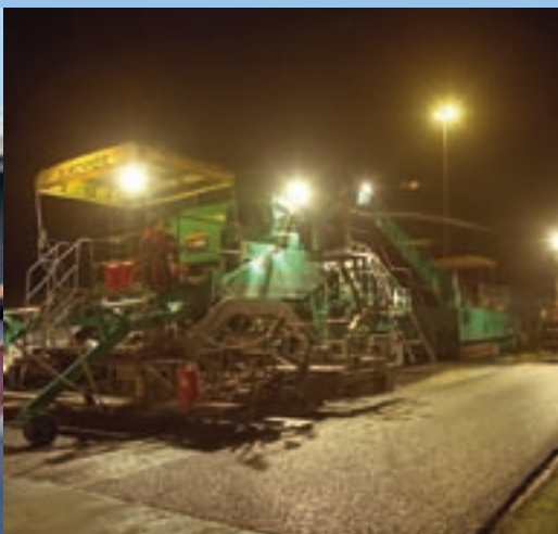
Twelaags asfaltspreidmachine op de A27 bij Hilversum
