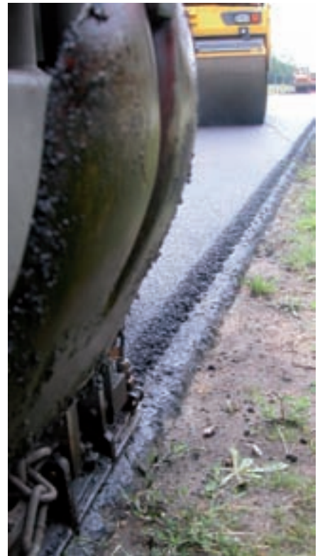
De hoogte van de eerste laag is de maat voor de aansluiting.
