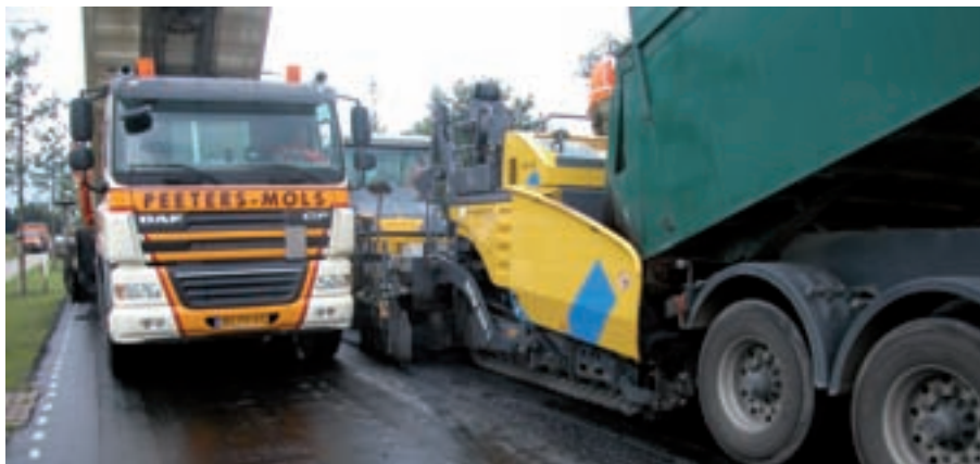
Kort op elkaar werkende asfaltspreidmachines.
