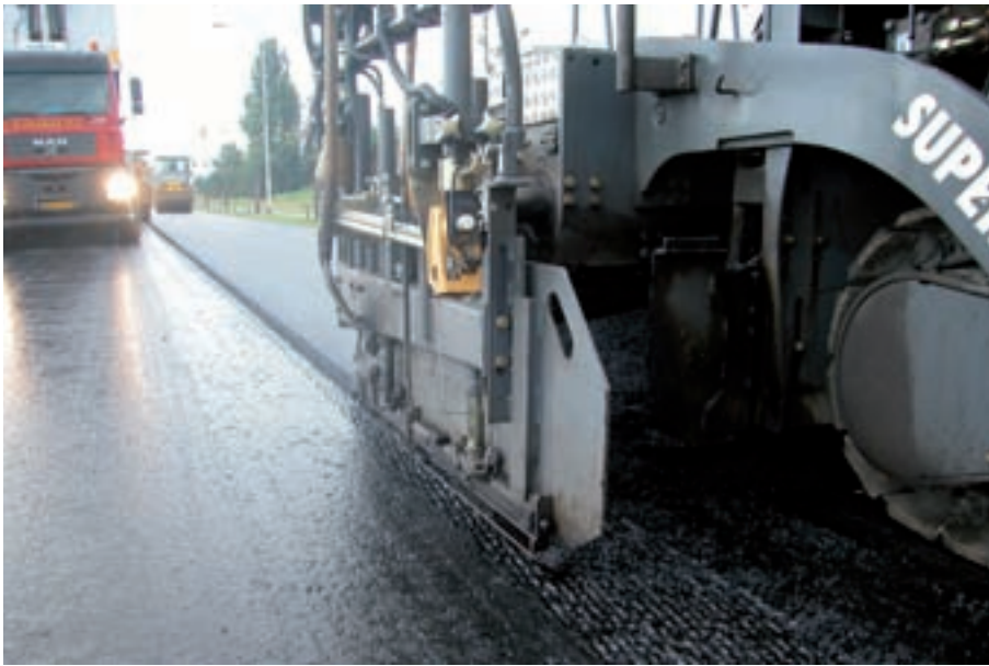
Een dikke kleeftlaag is bij dit mengsel gewenst.
