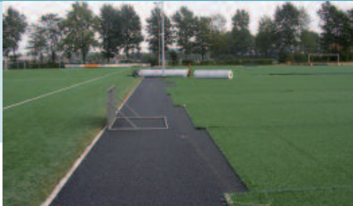
15. Passen en meten van kunstgrasmat op asfalt werkt veel gemakkelijker zonder schade aan de onderlaag.
