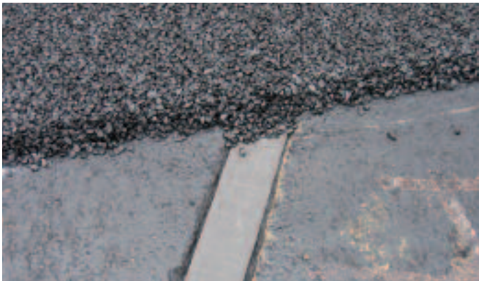
11. Optioneel extra drain onder de drainasfalt deklaag.
