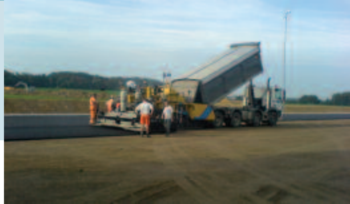
10. Aanbrengen asfaltonderlaag. Twee lagen asfaltbeton die leiden tot een optimaal vlakke ondergrond voor de toplaag kunstgras.
