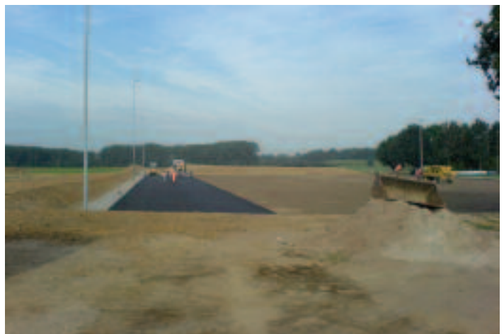
8. Fase 2 van het ECO systeem. Asfaltbeton in twee lagen en dan zo vlak als een groen biljartlaken.
