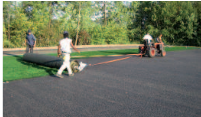
12. Uitrollen kunstgras direct op de drainasfalt deklaag: snel en met beperkte inspanning.
