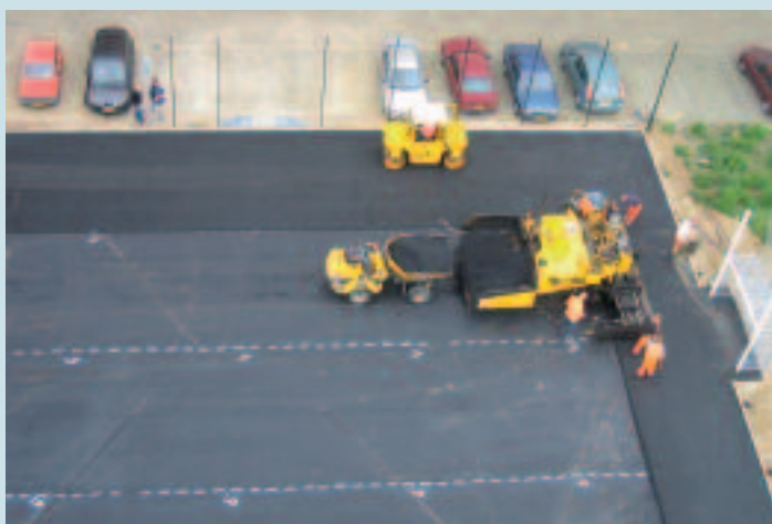
3. Aanbrengen drainasfalt deklaag met een tolerantie op de vlakheid van “nul”. Vakmanschap is hier een absolute vereiste.
