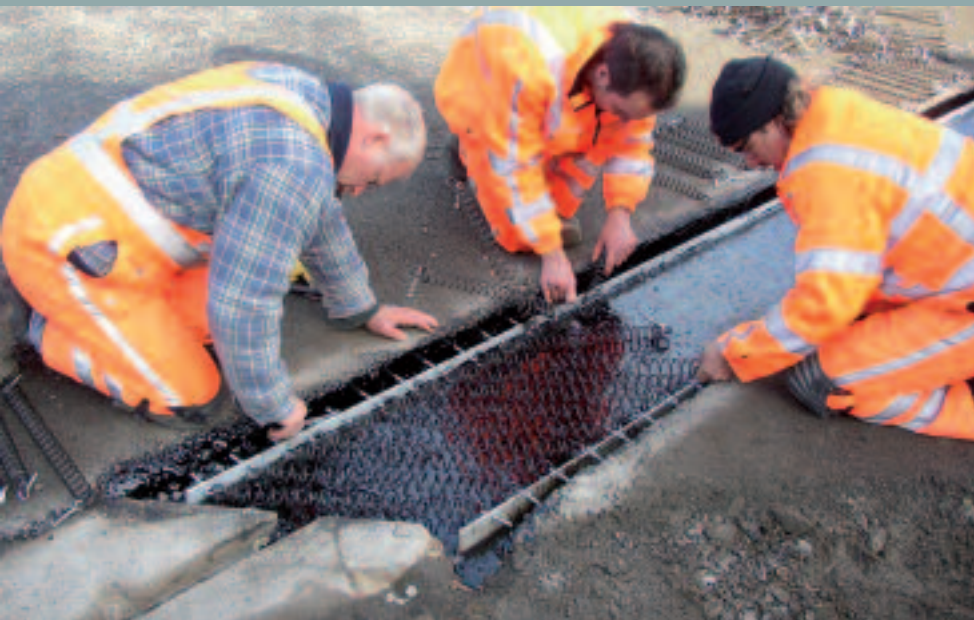
Aanbrengen stalen wapeningsveren tussen hoekprofielen.
