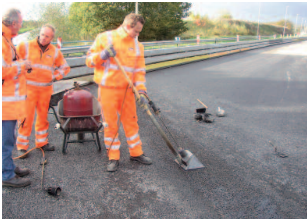
Laatste afwerking voor openstelling voor het verkeer.
