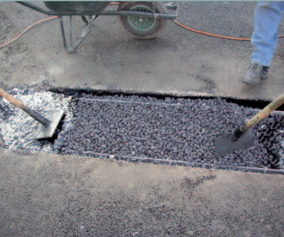
Hete grof gegradeerde aggregaat goed tussen de veren verdelen.
