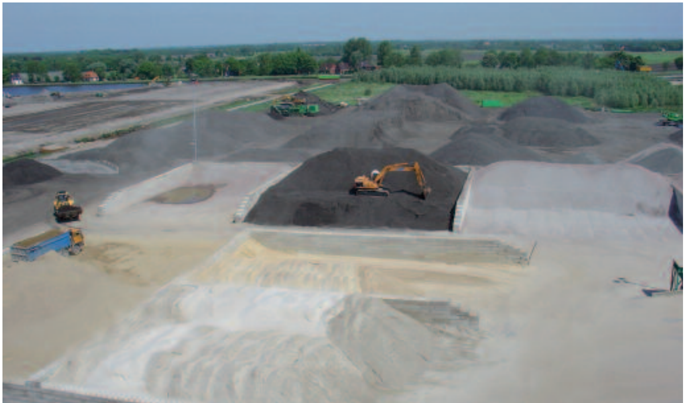
Warm hergebruik van schoon freesmateriaal in nieuw asfalt
