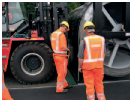
Begin mat exact boven aansluiting
