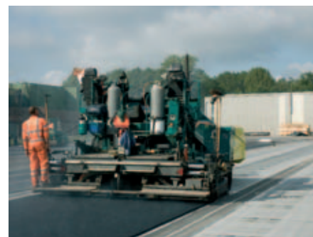
Aanbrengen asfalt
