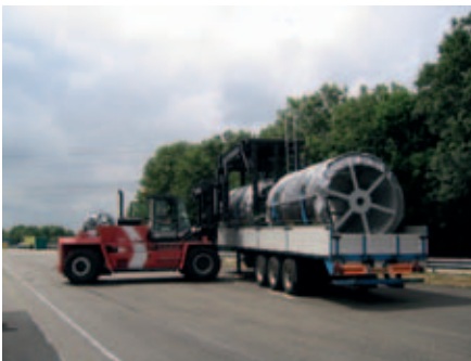
Lossen haspels van 17 ton op het werk
