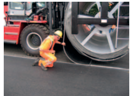
Laatste controle op aansluiting
