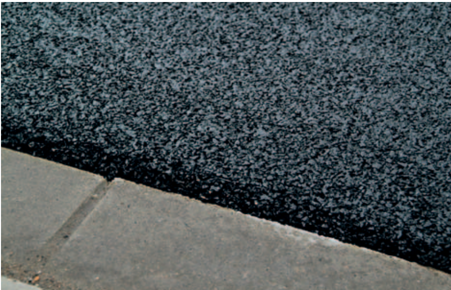
Detail rand direct na aanleg
