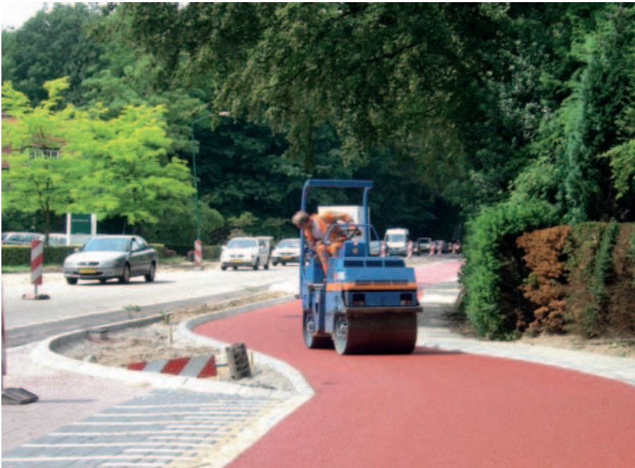
Het zevenkilometer lange waterdoorlatende Gasfalt fietspad is in twee kleuren aangebracht: zwart en rood.
