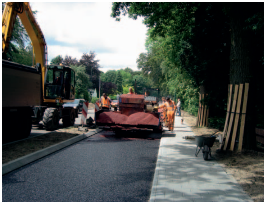
Bij de uitvoering mag de bovenste funderingslaag niet worden verbrijzeld. Daarom wordt de asfaltspreidmachine vanaf de zijkant gevuld.
