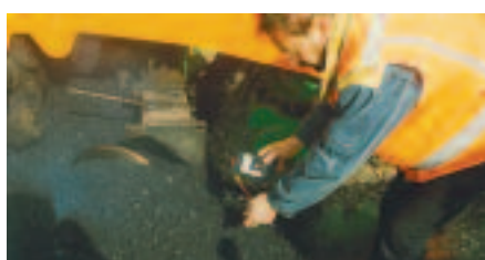
Metten, metten en nog eens metten
