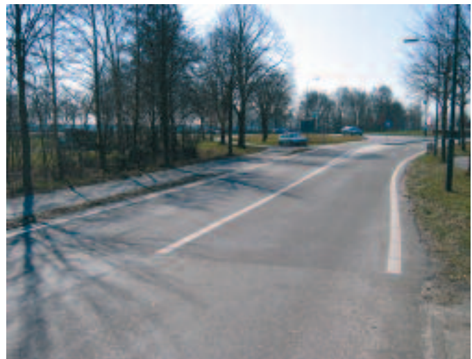
Overgang van het oude en het nieuwe wegvak
