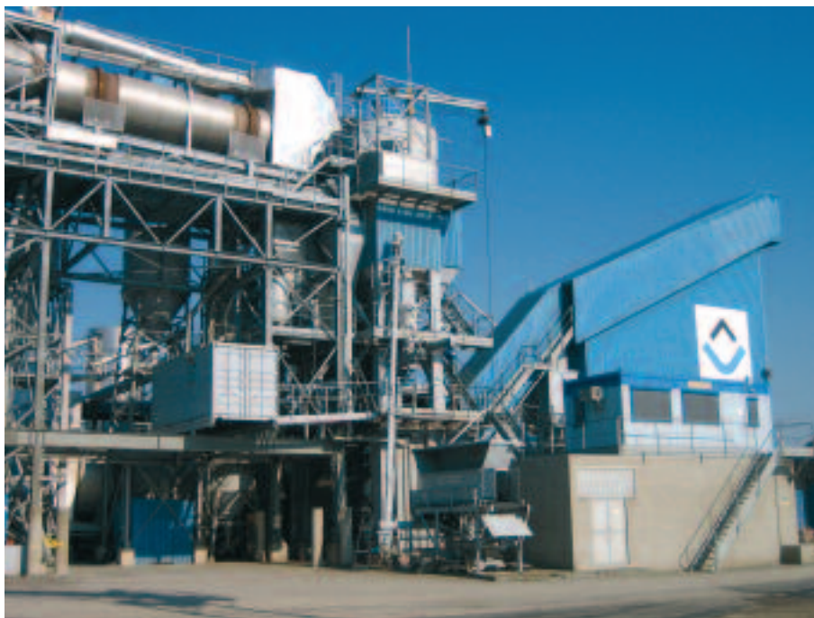
Asfaltfabriek Roermond met op de voorgrond de doseur, waar na enkele proef- en demovakken asfaltbeton wordt geproduceerd met de optie om granulaat (van dakbedekking) toe te voegen.
