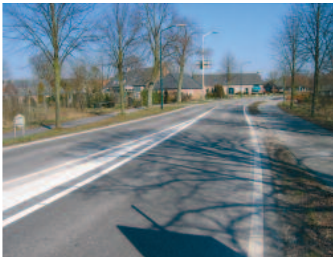
Het wegvak enkele maanden na openstelling
