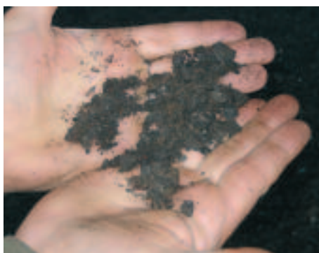
Granulaat van het oude dakleer
