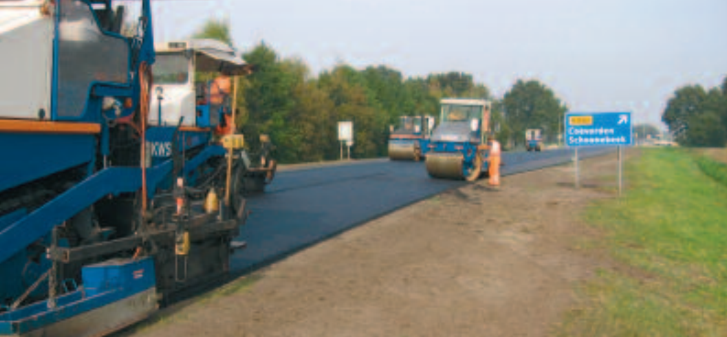
Aanbrengen deklaag op de N382 nabij km 2, oktober 2005
