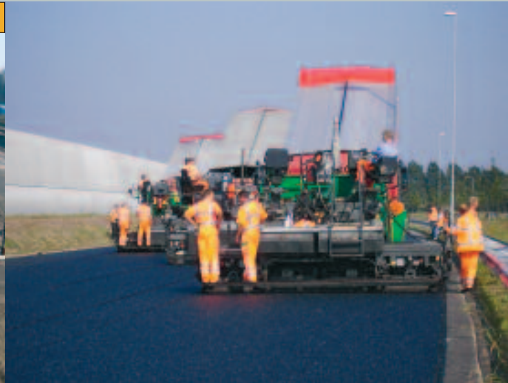
In de zomer van 2005 is tijdens 4 weekenden de ZOAB deklaag in gedeelten op de A59 aangebracht
