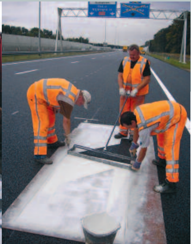
Ook de belijning en markeringen worden tijdens de ZOAB-weekenden aangebracht.
