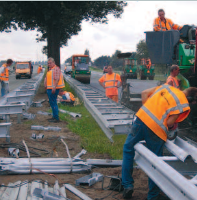
Tijdens het aanbrengen van de ZOAB deklaag wordt ook de laatste geleiderail en verlichting aangebracht
