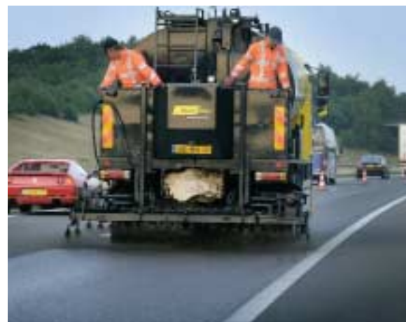
Uitvoering sealen van ZOAB met 3 km/uur
