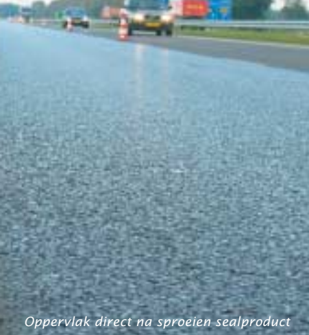
Aanbrengen speciale emulsie-asfaltbeton op ZOAB
