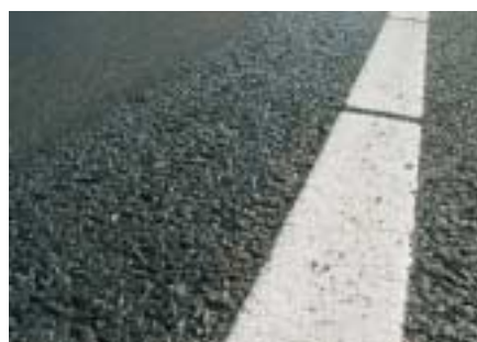
Linksboven EAB en tot de markering geseald ZOAB oppervlak
