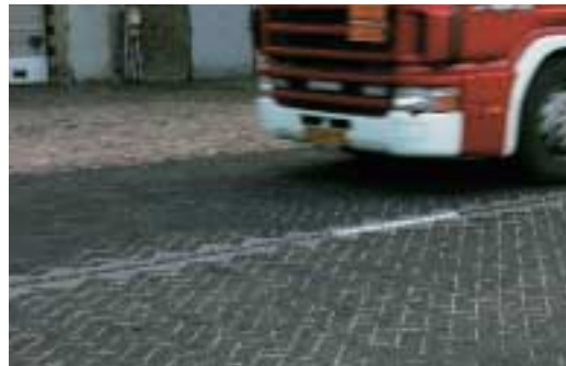
Elementenverharding van asfalt
