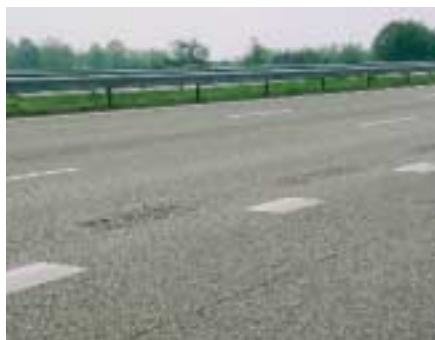
Proefvak RW 9 - verwijderen markeringen
