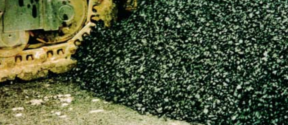
Spreiden ZOAB-mengsel
