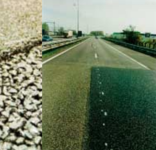
Proefvak RW 22 - reparatietechnieken
