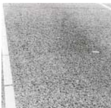
Spreiden ZOAB-mengsel
