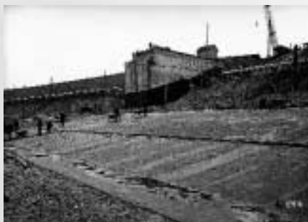
Het eerste grote waterbouwproject is de aanleg van het Julianakanaal. In 1934 werd een deel van het kanaal voorzien van een waterdichte asfaltlaag
