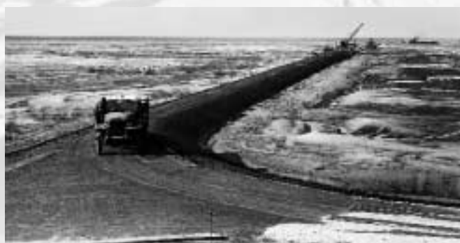
Het eerste grote waterbouwproject is de aanleg van het Julianakanaal. In 1934 werd een deel van het kanaal voorzien van een waterdichte asfaltlaag
