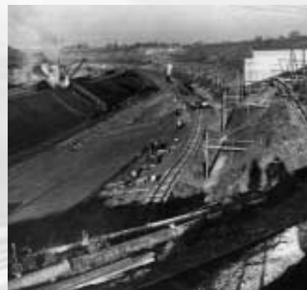
Het eerste grote waterbouwproject is de aanleg van het Julianakanaal. In 1934 werd een deel van het kanaal voorzien van een waterdichte asfaltlaag
