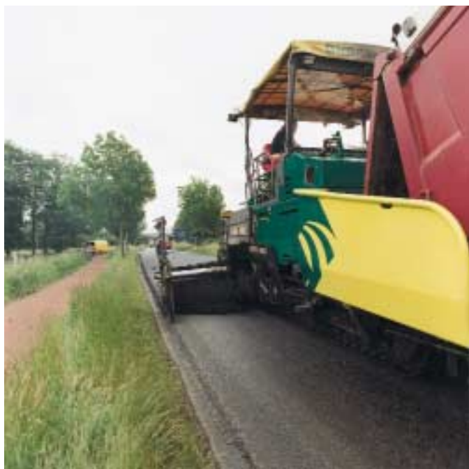
Aanbrengen profieleerlaag Rijkevoortseweg Boxmeer
