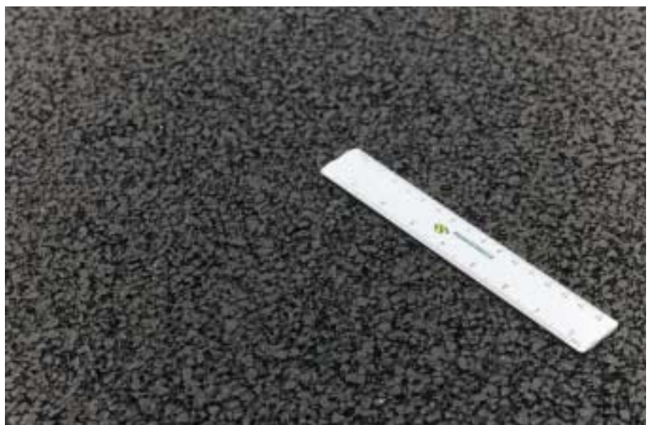
Oppervlak microdeklaag
