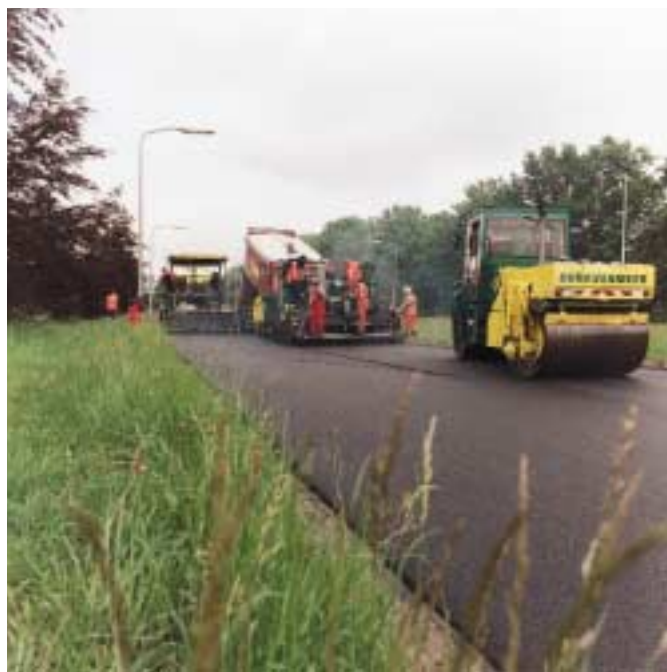
Verwerking microdeklaag Neerboscheweg Nijmegen
