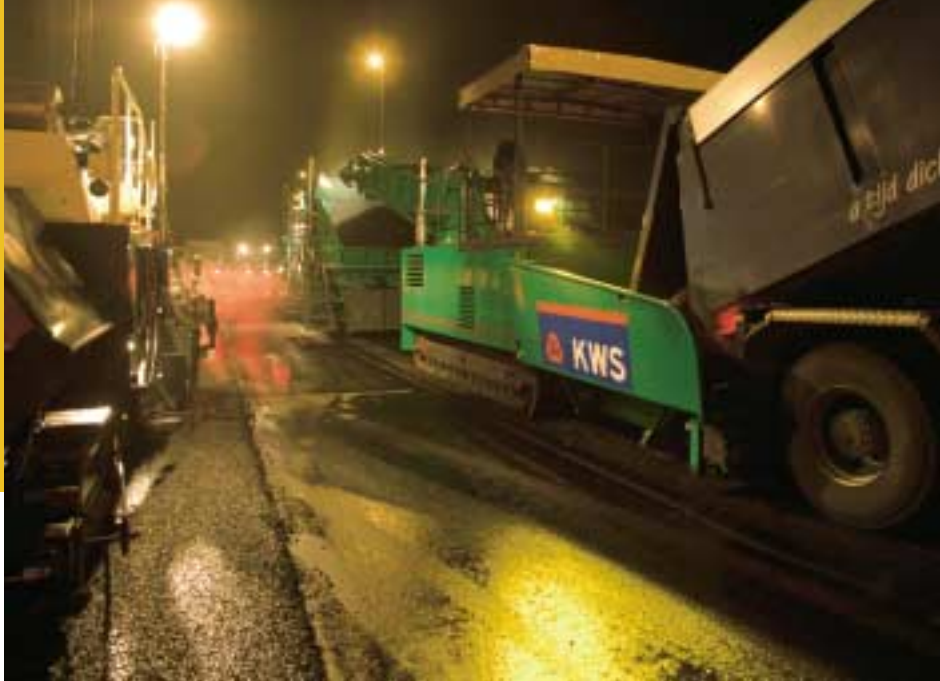
Aanbrengen deklaag op vluchtstrook
