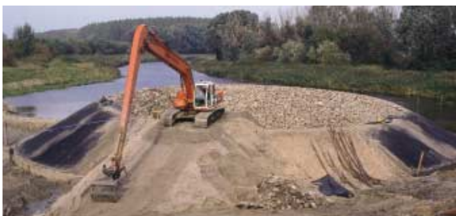
Tijdelijke hellingbaan zodat de kraan die het binnendeel uitgroef het eiland kon verlaten; binnentalud met steen bekleed
