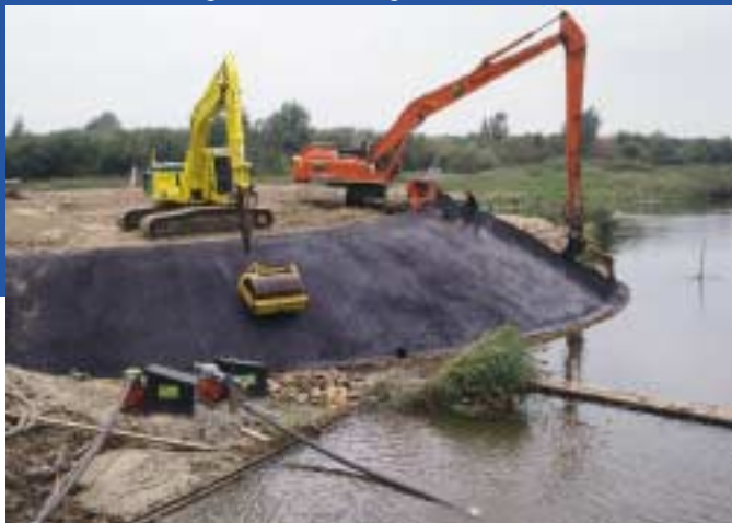
Wals aan kraan zorgt voor verdichting
