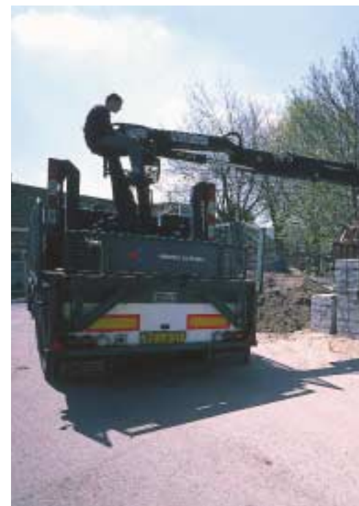
Bezoek aan de bouwplaats
