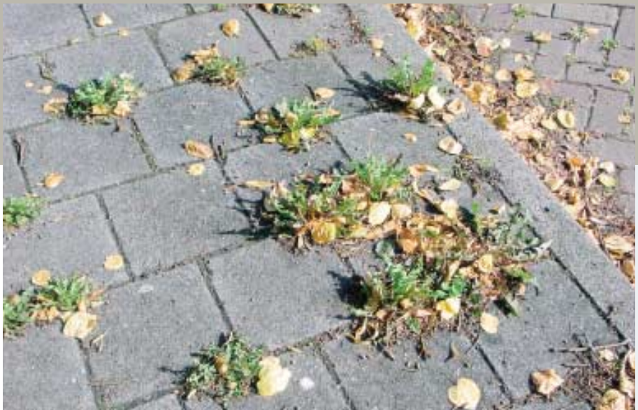
Onderhoud en beheer al in de voorbereiding te betrekken
