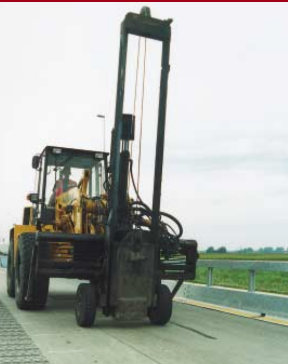
Ontspannen betonverharding volgens guillotine methode
