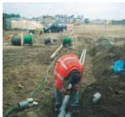
Mantelbuizen voor kabels
