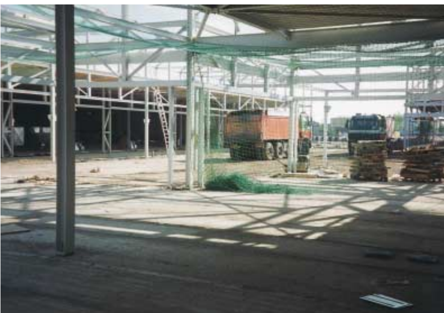
Tijdens de bouw de asfaltverharding aanbrengen vereist manoeuvreren
