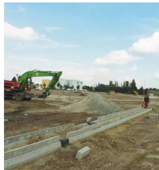
Aanbrengen fundering en kantopsluiting
