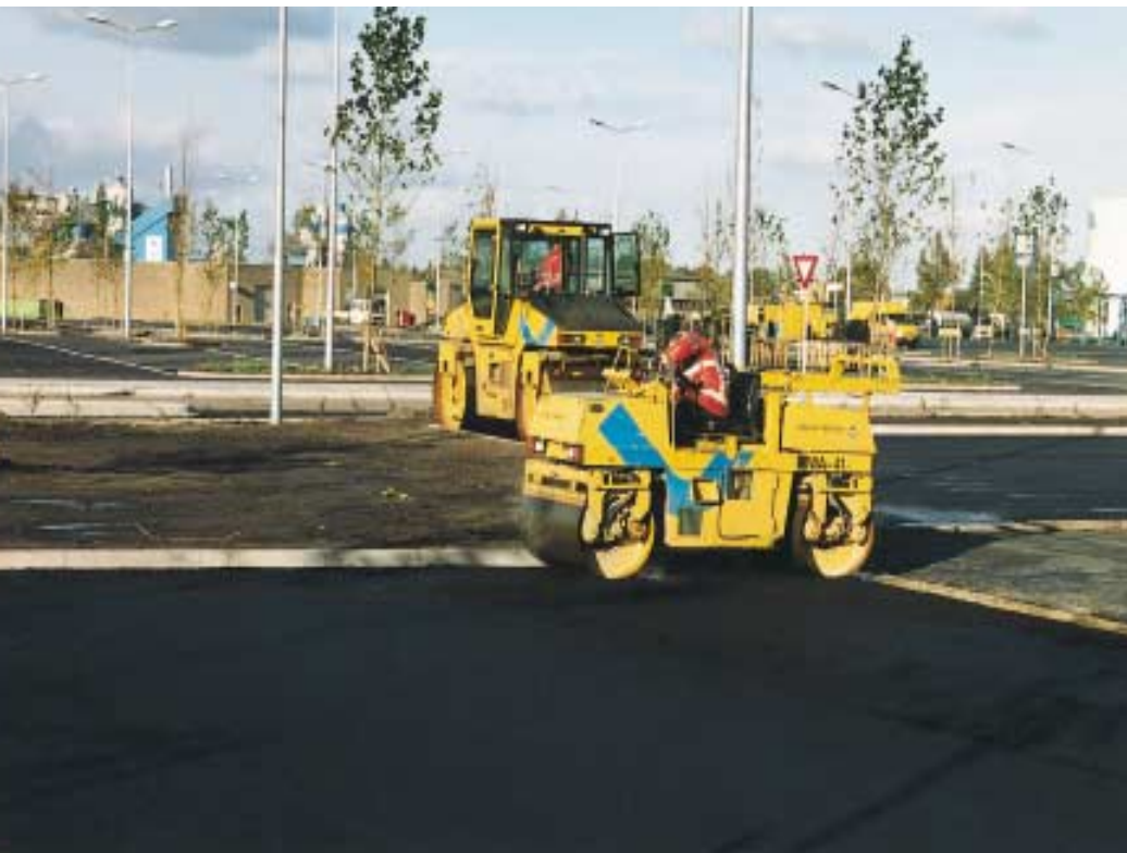
Nauwkeurig hoeken verdichten, asfaltcentrale op achtergrond
