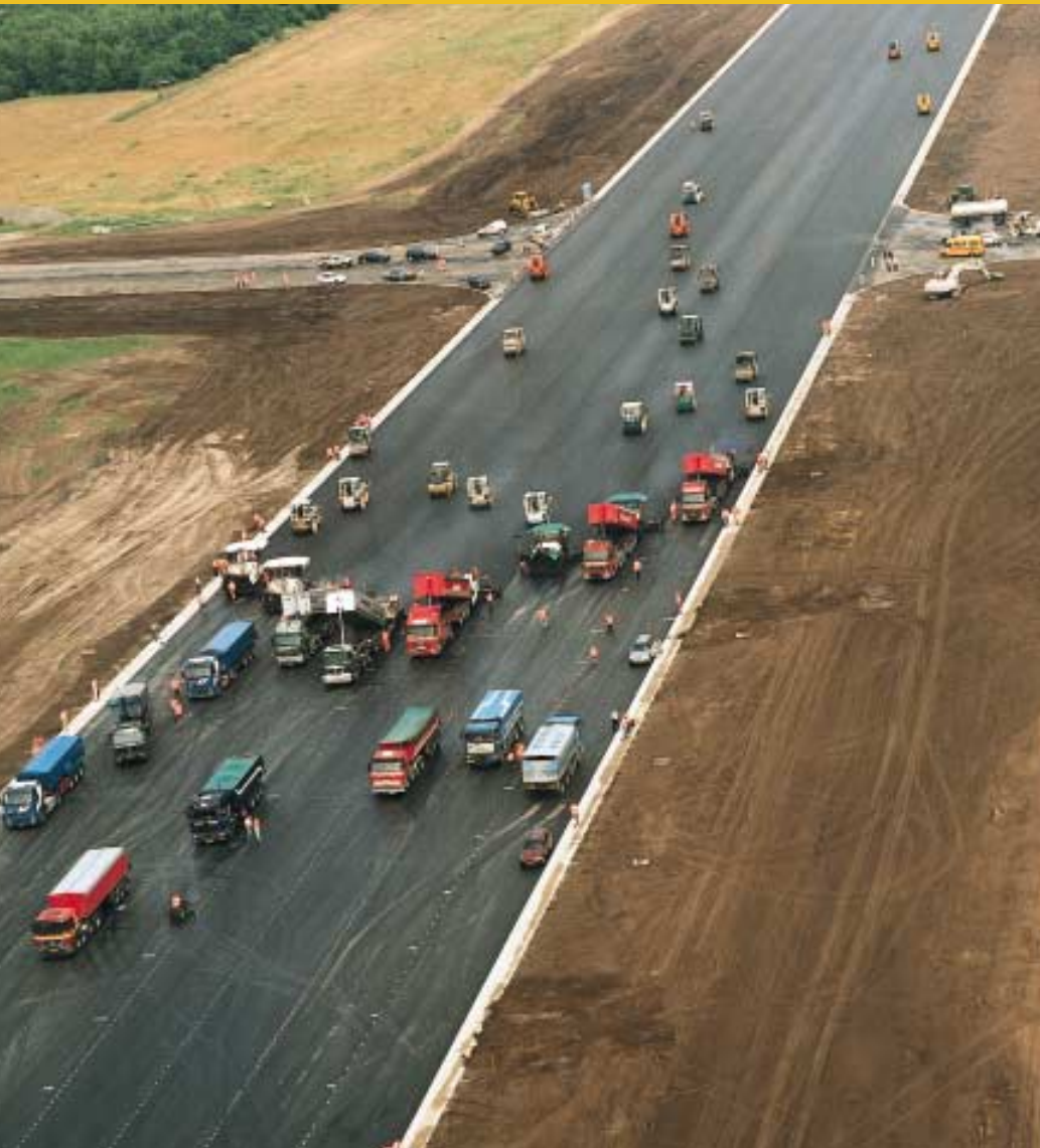
Aanbrengen asfaltverharding
