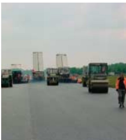
Warm in warm verwerken asfalt
