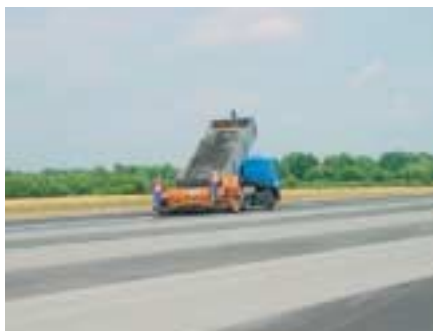
Aanbrengen anti skid laag
