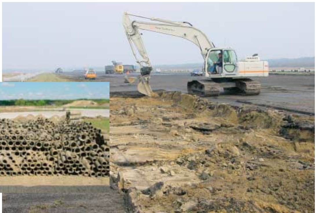
Uitbreken sandwichconstructie
