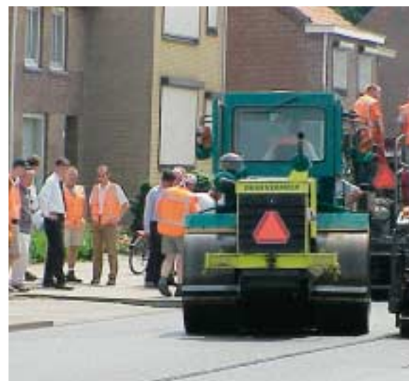
Tijdens het aanbrengen van de asfalt-overlaging is een demo-dag georganiseerd
