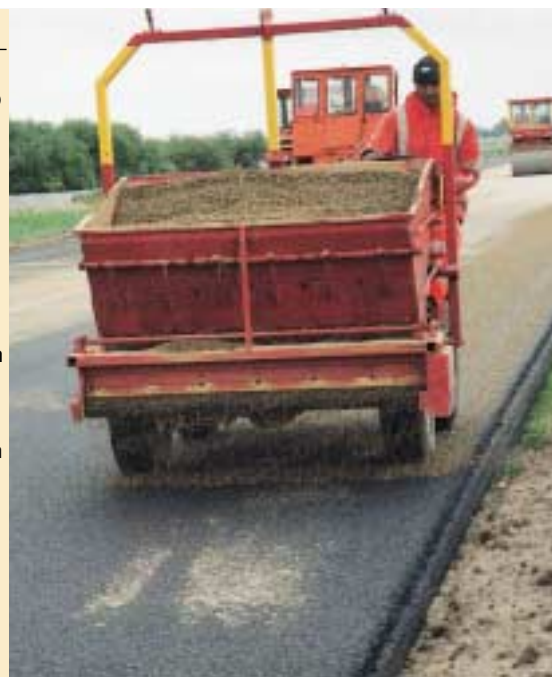
Afstrooien SMA op proefvakken A6
