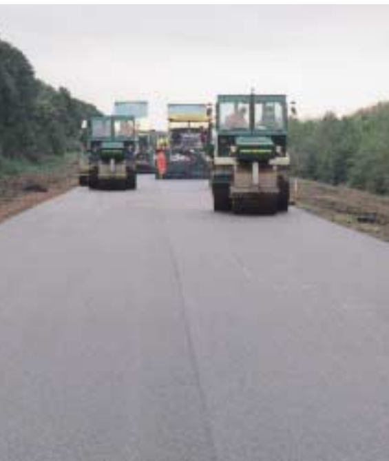
Deklaag in één werkgang met twee afwerk machines
