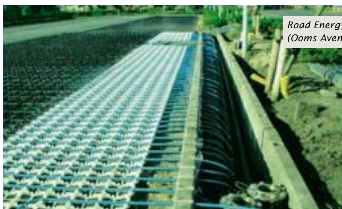
Ingegoten leidingen in asfalt
