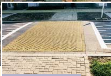
Asfaltdrempel in woonwijk
