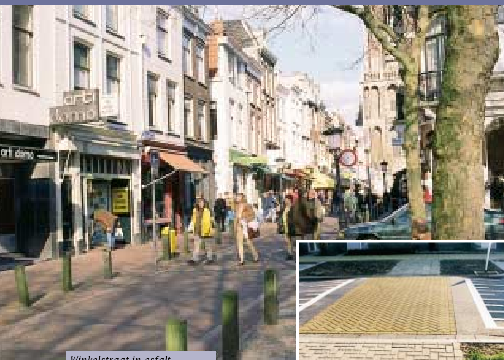
Winkelstraat in asfalt
