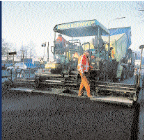
Balkbreedte links en rechts blijvend controleren
