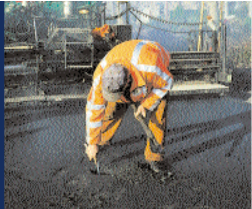
Controle op laagdikte. Hier door wat uit te graven maar meestal is prikken met een duimstok voldoende.
