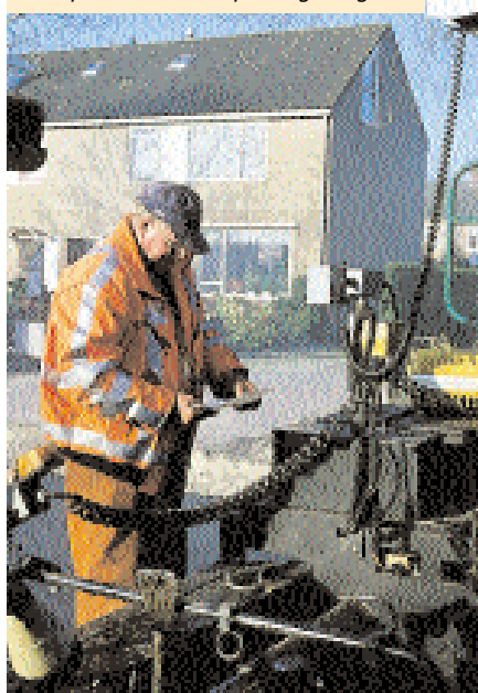
Controle weegbon die de chauffeur bij de asfaltcentrale heeft meegekregen
