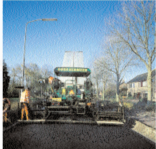
Een strak en vlak wegdek met enige tonronde zodat het regenwater naar de zijkanten stroomt
