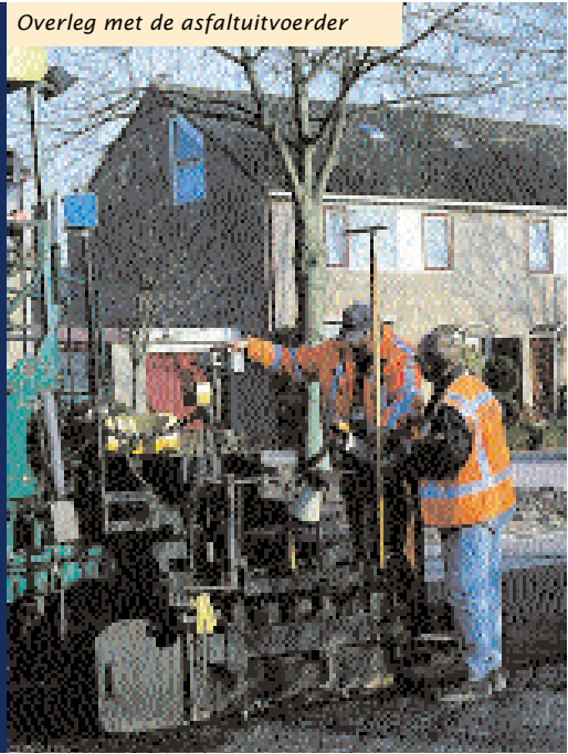
Overleg met de asfaltuitvoerder
