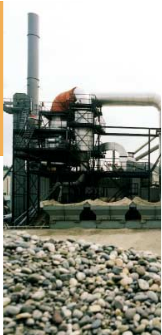
Overzicht asfalt installatie
