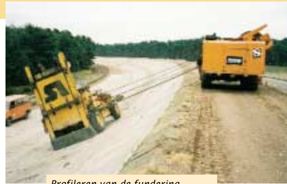
Profileren van de fundering
