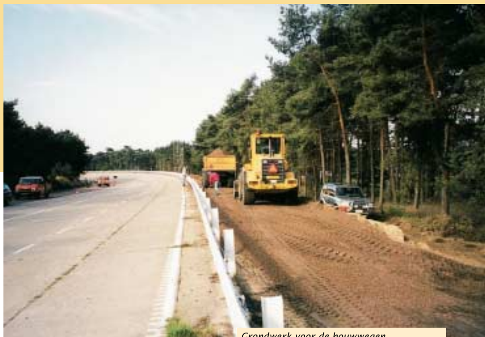
Grondwerk voor de bouwwegen
