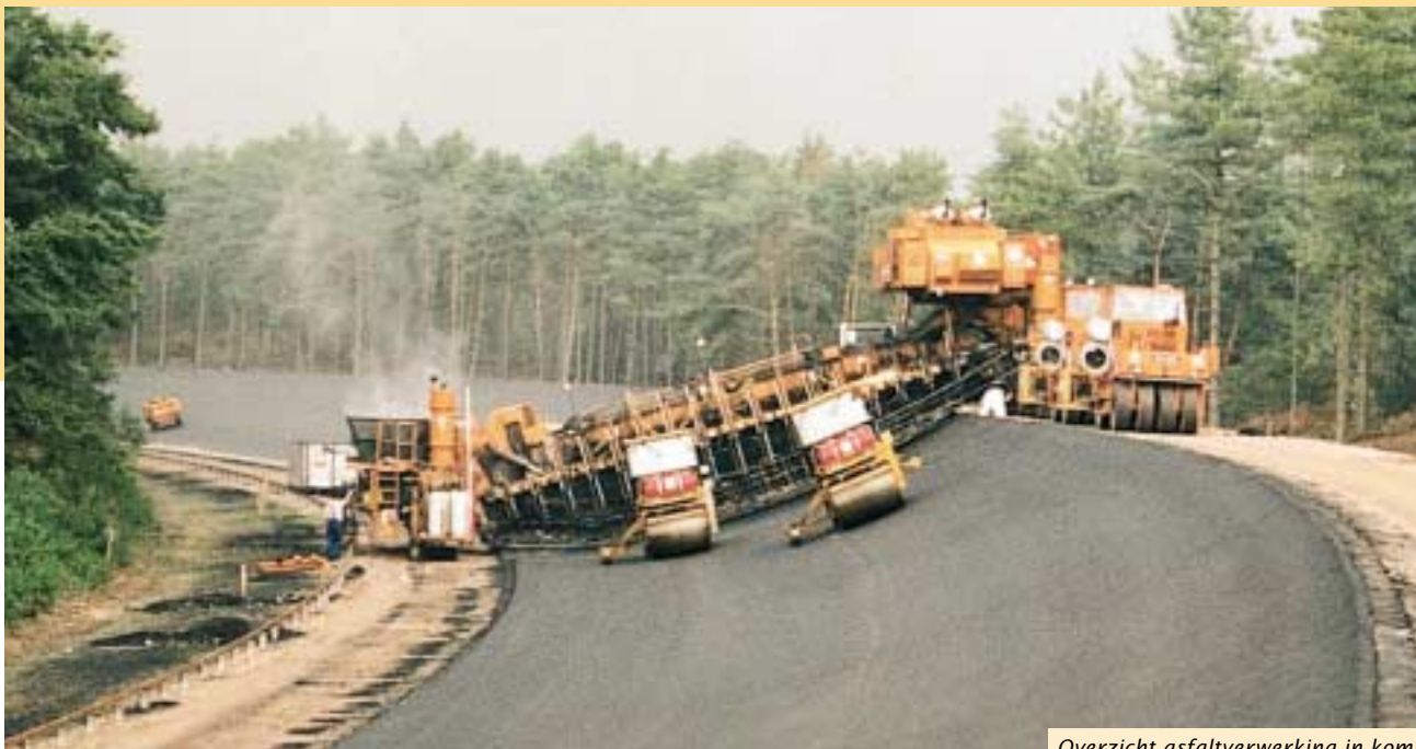
Overzicht asfaltverwerking in kombochten
