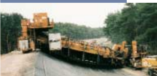
Aanbrengen asfalt in de krombochten met de 'Brückenfertiger'
