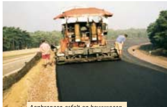
Aanbrengen asfalt op bouwwegen
