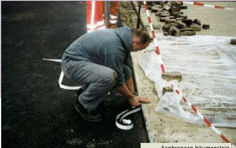
Aanbrengen bitumenstrip
