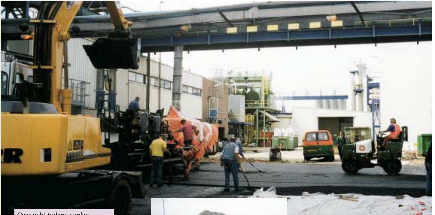
Overzicht tijdens aanleg
