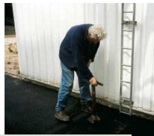
Verdichting bij randen en aansluitingen
