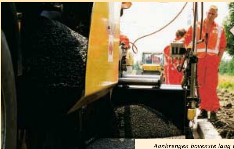
Aanbrengen bovenste laag tweelaags zoab langs afwateringssysteem
