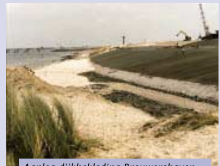
Aanleg dijkbekleding Brouwershaven
