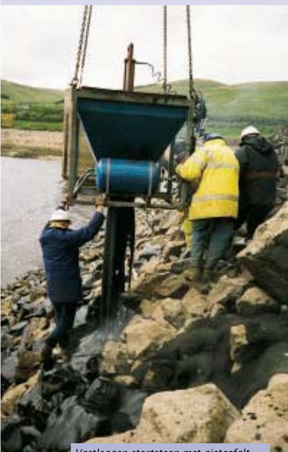
Vastleggen stortsteen met gietasfalt
