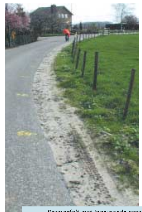
Bermasfalt met ingeveegde grond
