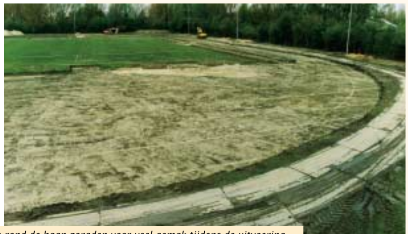
Rijplaten rond de baan zorgden voor veel gemak tijdens de uitvoering
