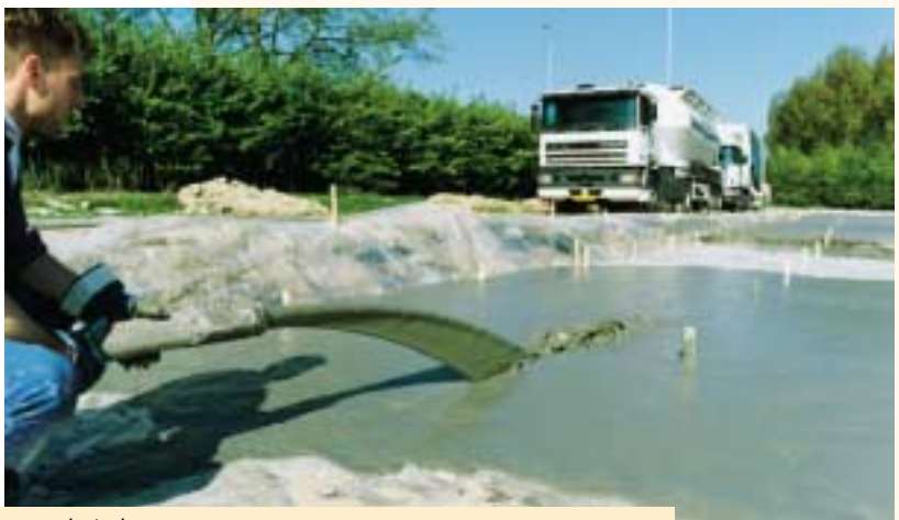
Aanbrengen schuimbeton
