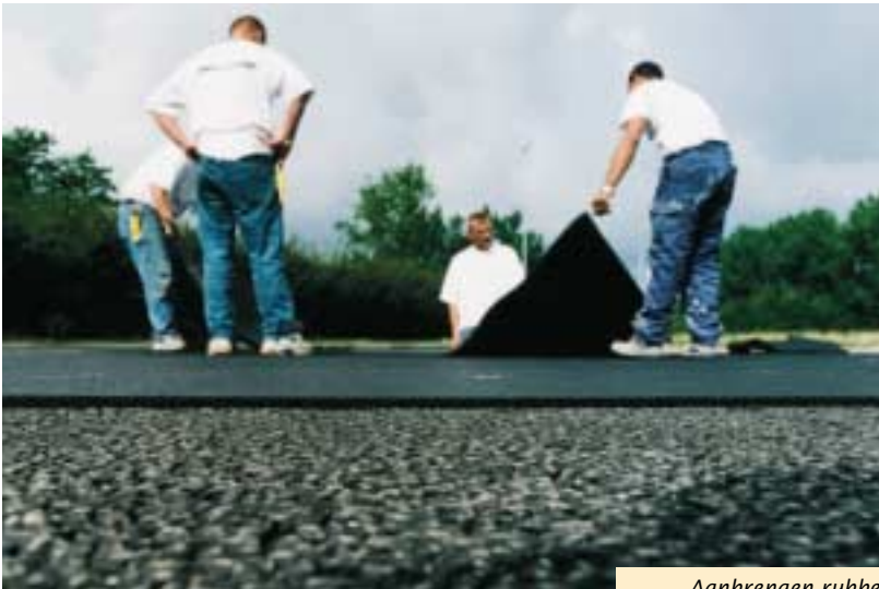
Aanbrengen rubber mat
