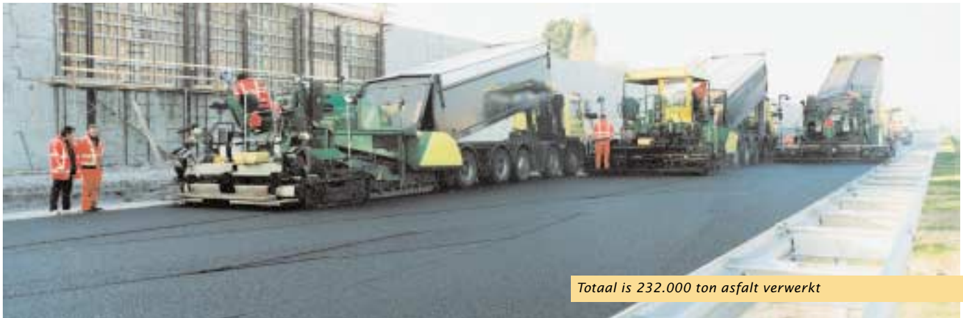
ZOAB aanbrengen met drie machines naast elkaar
