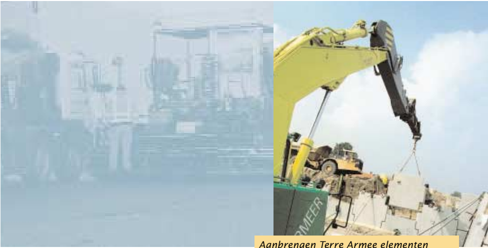
Aanbrengen Terre Armee elementen
