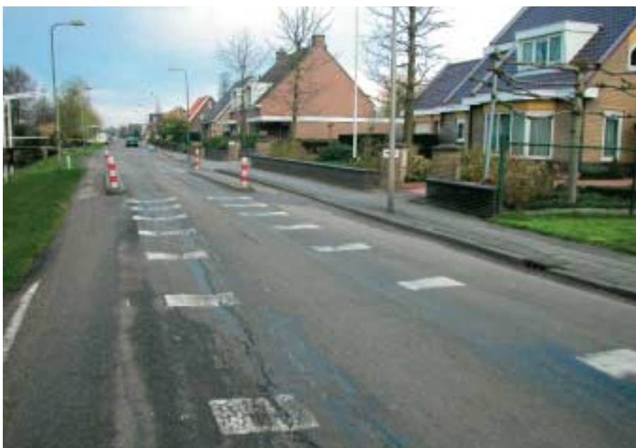
Aanbrengen verkeerssluis leidt tot dubbele verkeersbelasting en sterk sporend verkeer
